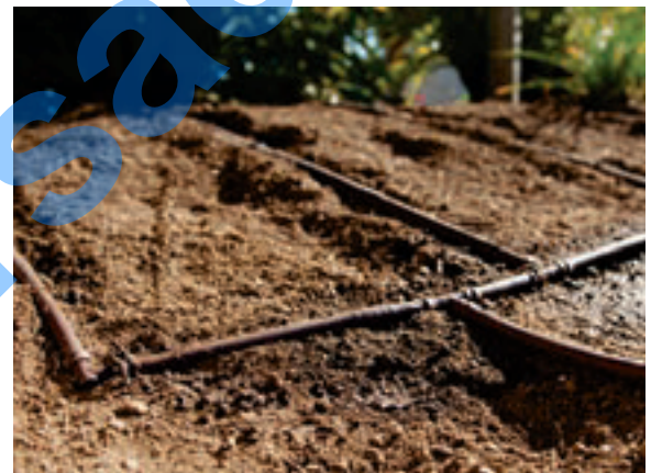
Nainštalované potrubie PLD
