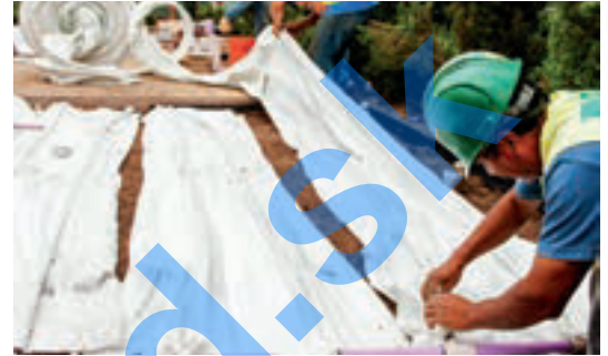
Nainštalovaná rohož Eco-Mat
